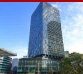
大名古屋ビルテング
