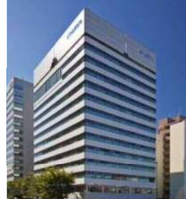
SE札幌ビル
