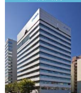
SE札幌ビル
