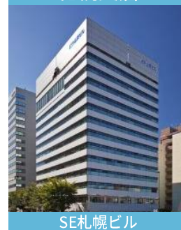
SE札幌ビル
